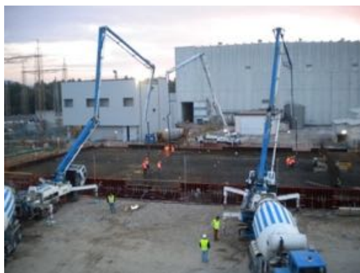
Messa in sicurezza Centrale Nucleare del Garigliano SOGIN SESSA AURUNCA (CE)
