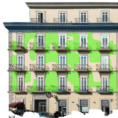
Anomalie termiche Individuazione delle anomalie termiche su fotoraddrizzamento
