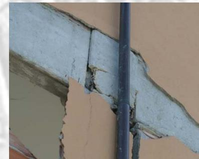
**Carenza di armature trasversale nel pannello di nodo**
