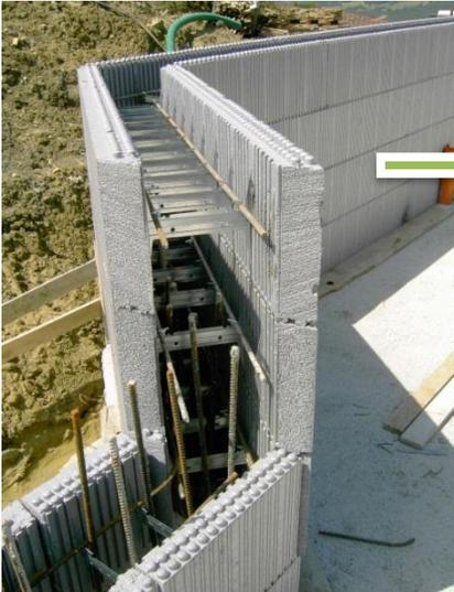
I «blocchetti» sono realizzati utilizzando inserti in materiale plastico o metallico che coniugano la faccia interna con quella esterna e presentano elementi sup. e inf. Per l'incastro a secco al fine di realizzare corsi successivi
