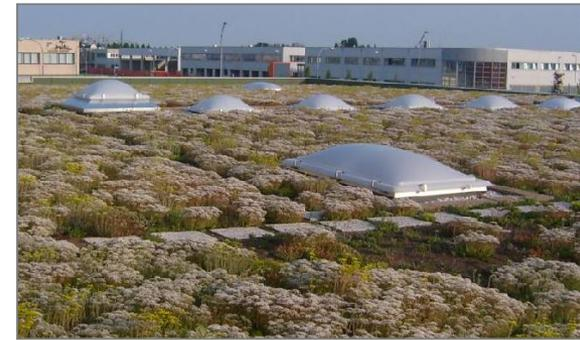
*... I pannelli in EPS sono da sempre impiegati come strato termoisolante nella realizzazione di “tetti verdi” ...*
