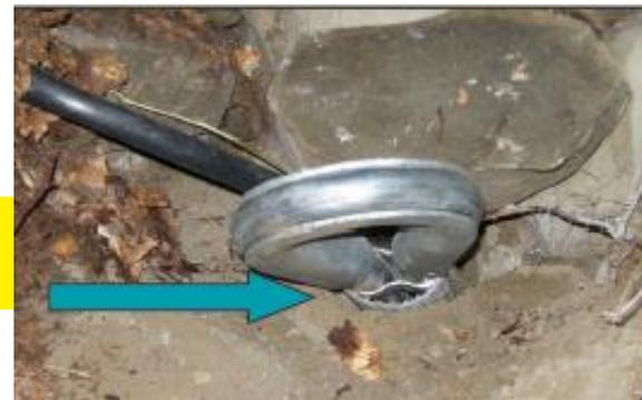
Dove il foro non si autosostiene, con reticella a sostegno della parete del foro, iniezione a fondo foro
