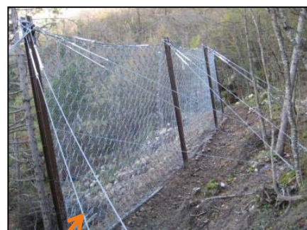
Componenti di connessione (funi, morsetti, grilli...)
