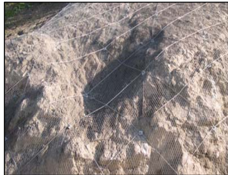
Interventi nella zona di distacco
