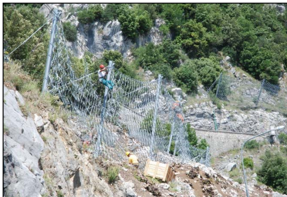
Installazione della rete principale e della rete secondaria
