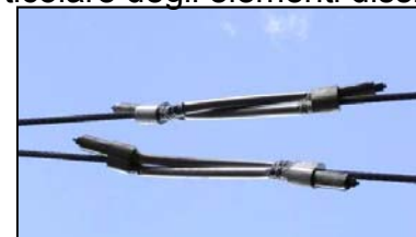
Particolare degli elementi dissipatori
