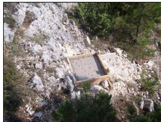
Getto del plinto di livellamento
