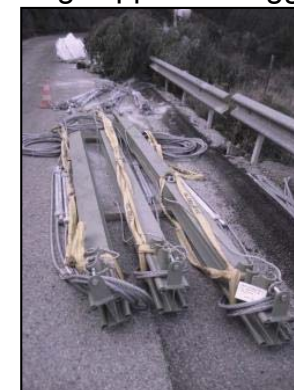
Montanti con controventi inseriti negli appositi alloggi
