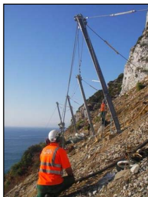
Installazione delle funi longitudinali superiori e inferiori
