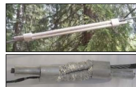
Dissipatori di energia
