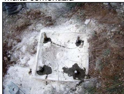
Alloggio barre di fondazione del montante e iniezioni di malta cementizia
