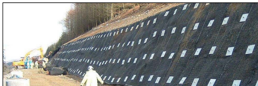
Rivestimento anti-erosivo di scavi definitivi
