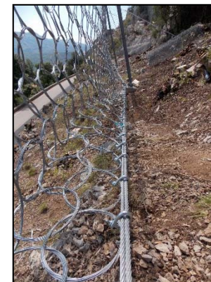
Installazione della rete principale e della rete secondaria
