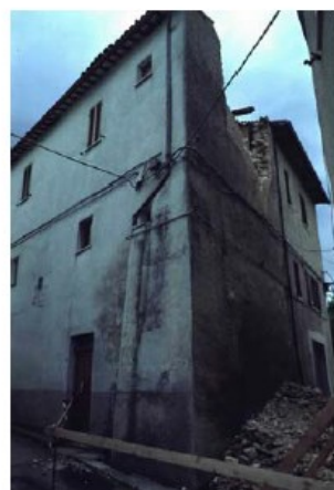
Fig. 1.3 – Meccanismi di flessione orizzontale
