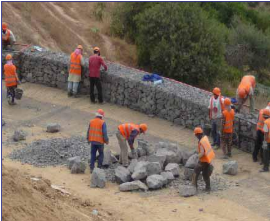
Spaccare massi sopra i rinforzi...
