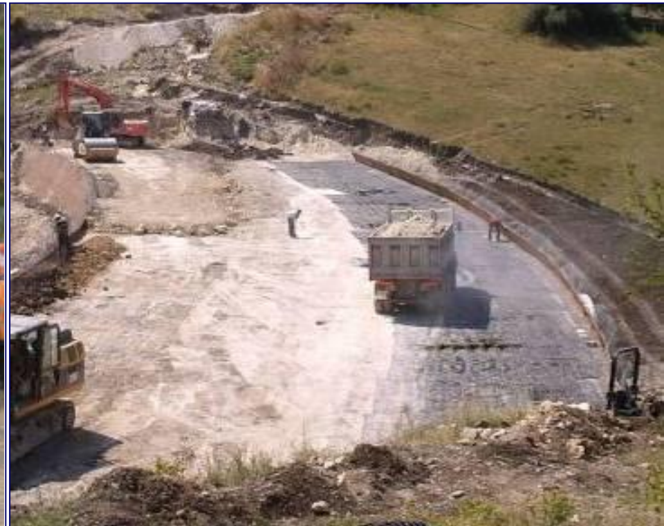
Transitare con i veicoli sopra i rinforzi...
