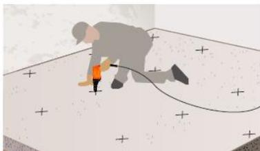
**2** Eseguire il preforo con un trapano e una punta da 8 mm.
