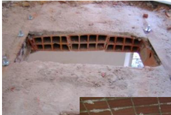
Singolo tavellone con cappa in calcestruzzo.
