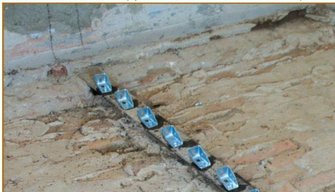
Connettore non industrializzato (tipo sistema "Turrini-Piazza")
